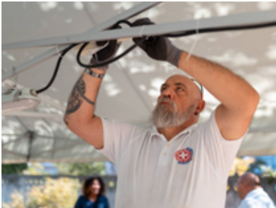
I volontari della Croce Bianca impegnati nei lavori per l'ampliamento del centro per i rifugiati con i partner a Kiev.
